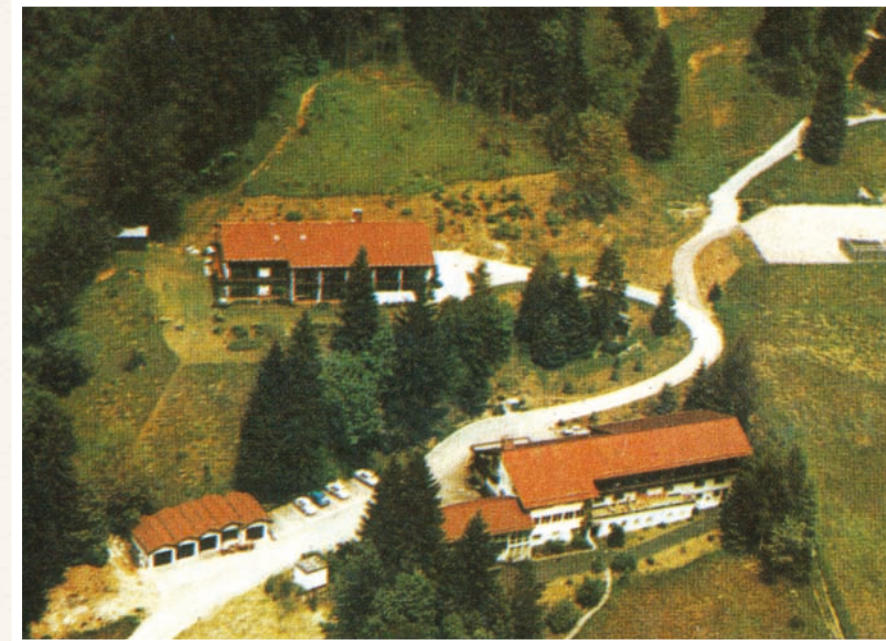
Neubau des Personalhauses und Anbau am Bettenhaus
